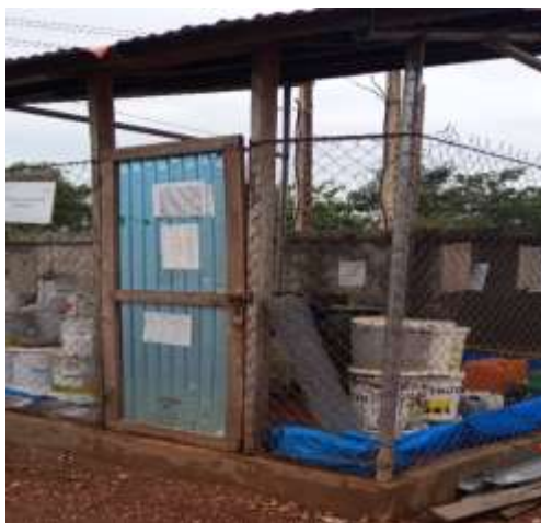
Photo 3 : Zone de stockage des produits et déchets dangereux
