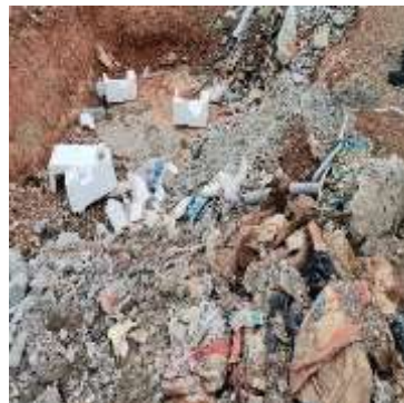
Photo 6 : Mélange de déchets dans la zone de stockage des gravats
