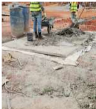
Photo 5 : Déversement du ciment
