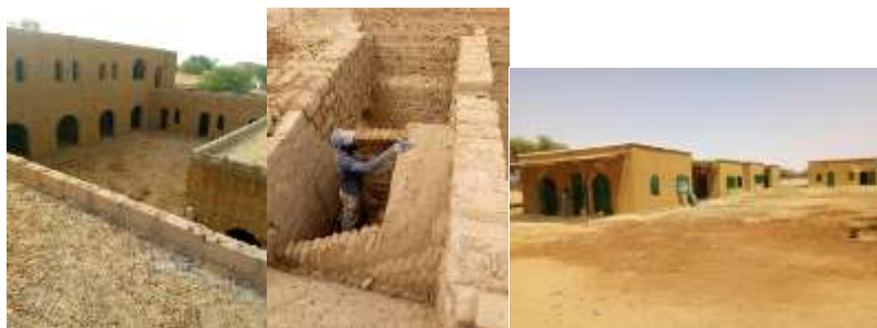
Planche 1 : Aperçus des constructions en voûte nubienne
