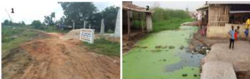
Planche 5 : Tracé viaire de l'école publique Tsiklonoukondji (1) et voie de desserte à Dabala Kondji (2)
