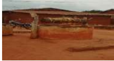
Photo 6: Puits traditionnels à manivelle à Gboli-Dakpa
