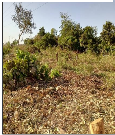
Photo N°2 : des arbres coupés sur l'emprise de la route.
