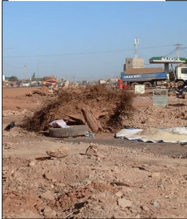
Photo N°1 : un arbre déraciné sur l'emprise De la route.
